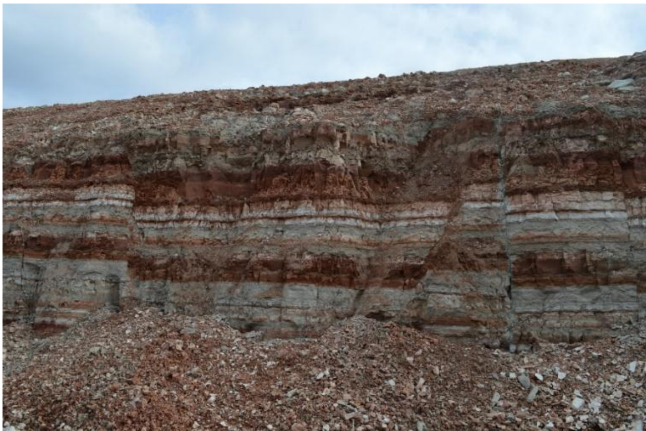
Рисунок 1. Фотография склона дорожной выемки, осложненного разрывными нарушениями
