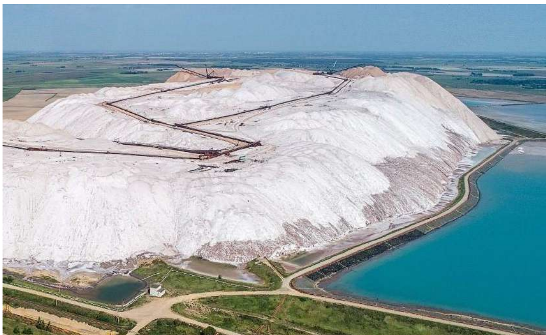
Рис. 2. Солеотвалы и шламохранилища Старобинского месторождения.
