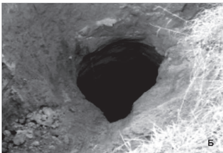
Рис. 5. Провал в МР Туймазинский район РБ: а — общий вид, б — «горловина» провала
